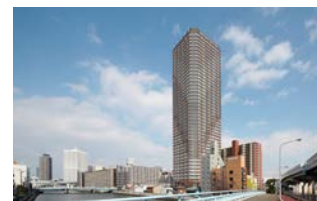
阿波座ライズタワーズ フラッグ46(565戸／2016年1月竣工／分譲済)
